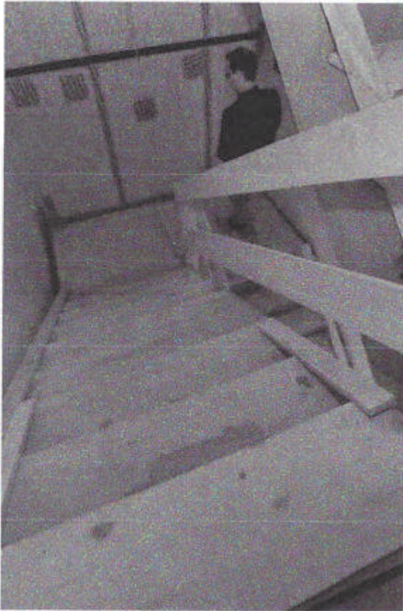
Der erste Rohbau der ökologischen Musteriedlung im Prinz-Eugen-Park steht. (Foto: Catherine Hees)
