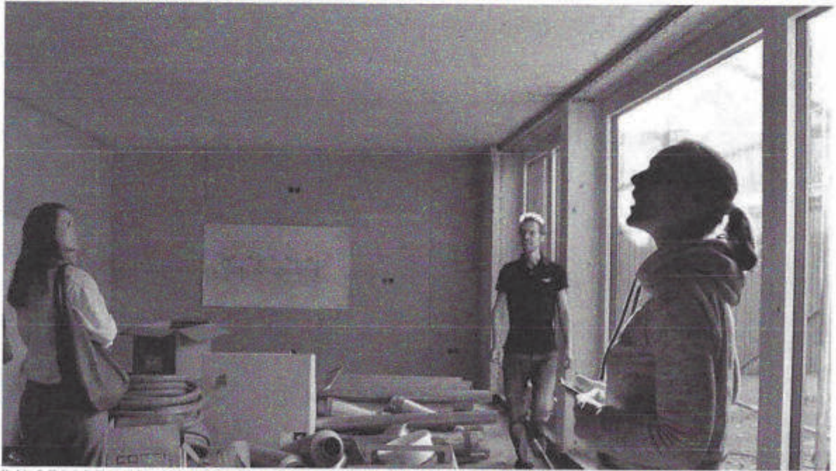
Noch ist die ökologische Mustersiedlung eine Baustelle. Doch schon im Mai oder Juni dürfen die ersten Familien einziehen. (Foto: Catharina Hess)
